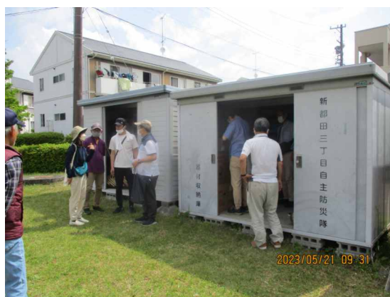
防災倉庫点検
